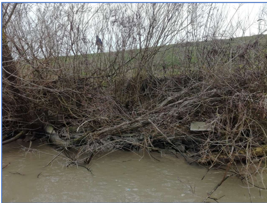
Foto 2 – Erosione della piarda (sez. 4)
