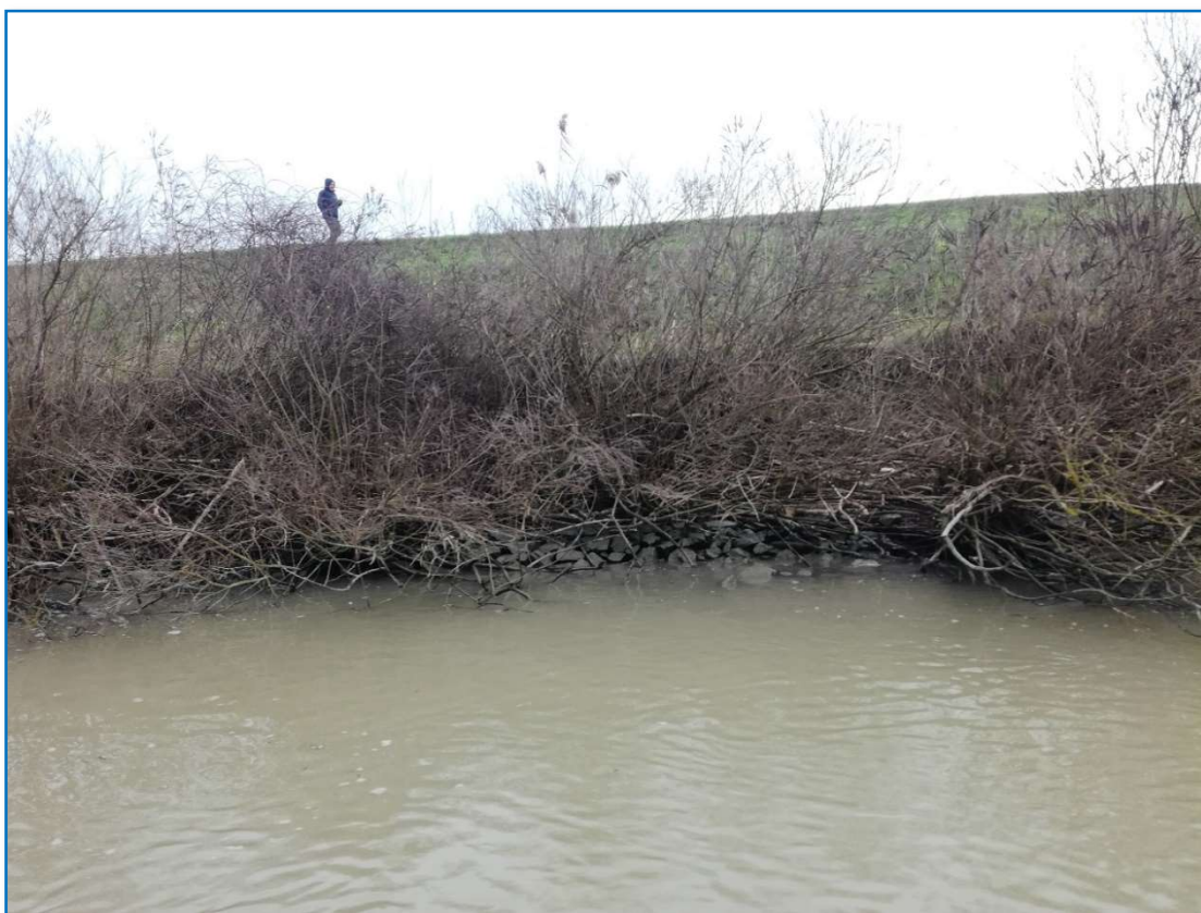
Foto 4 – Erosione della piarda (Sez. 6)
