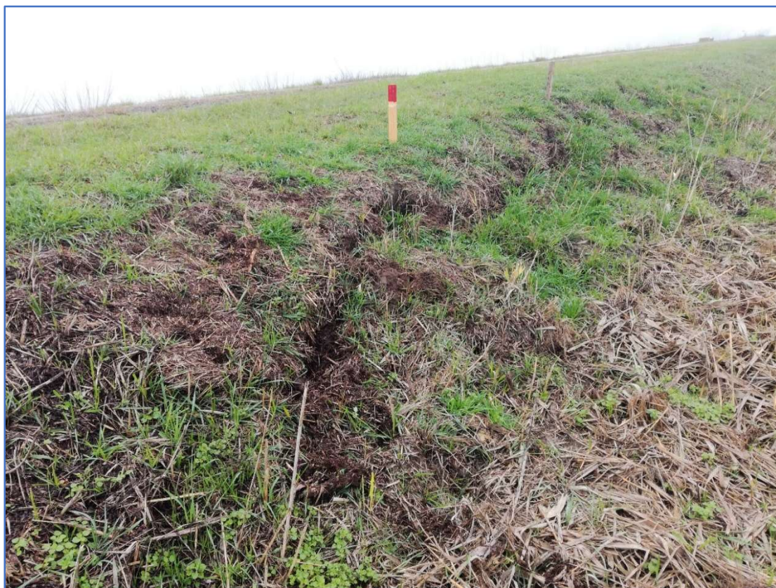
Foto 1 – Fessurazione sulla scarpata alta (sez. 6)
